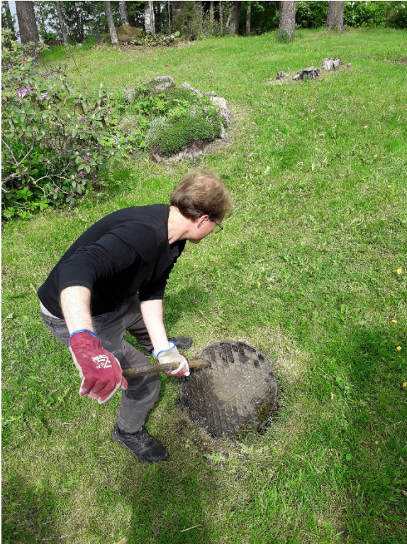
Kuva 4. Saostussäiliöiden kunto ja toimivuus tarkistetaan mahdollisuuksien mukaan avaamalla kannet.
