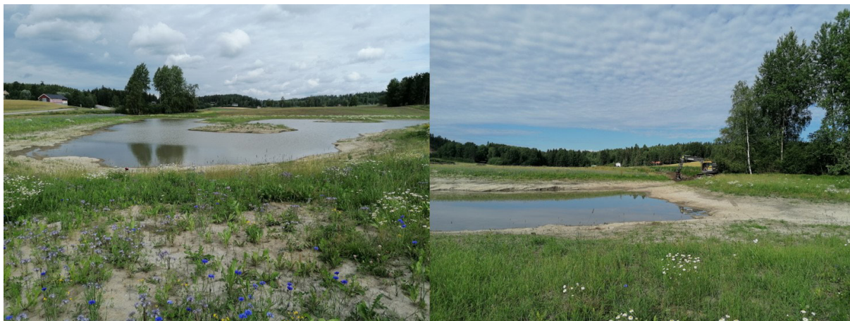
Kuva 2. Vasemmalla Vierelän kosteikko kesällä 2022 puroyhteyden avaamisen jälkeen kuvattuna Vihtijoen puolelta. Oikealla kaivinkone tekemässä puroyhteyden avaamista (LUVY / Virve Ståhl).
