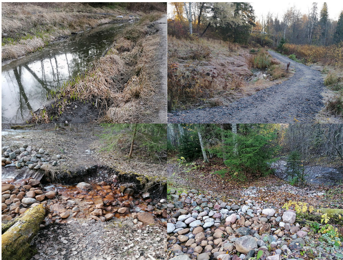
Kuva 3. Vasemmassa yläkulmassa Myllypuiston kosteikon vauriot ja oikealla yläkulmassa Myllypuiston kosteikko korjauksen jälkeen lokakuussa 2022. Vasemmalla alakulmassa Puhdistamontien vaurioitunut purkupaikka ja oikealla alakulmassa purkupaikka korjattuna lokakuussa 2022 (LUVY / Virve Ståhl).
