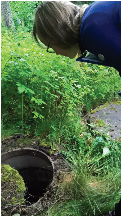
Kuva 4. Neuvoja kurkkaamassa kaivoon.
