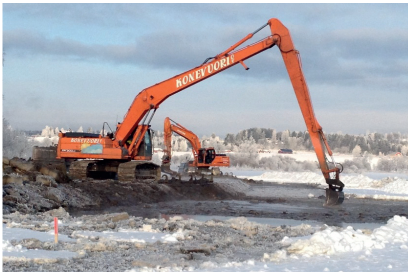
Kuva 10. Vanjärven ruoppaustyöt aloitettiin talvella 2013. Sanna Helttunen, Luvy ry
