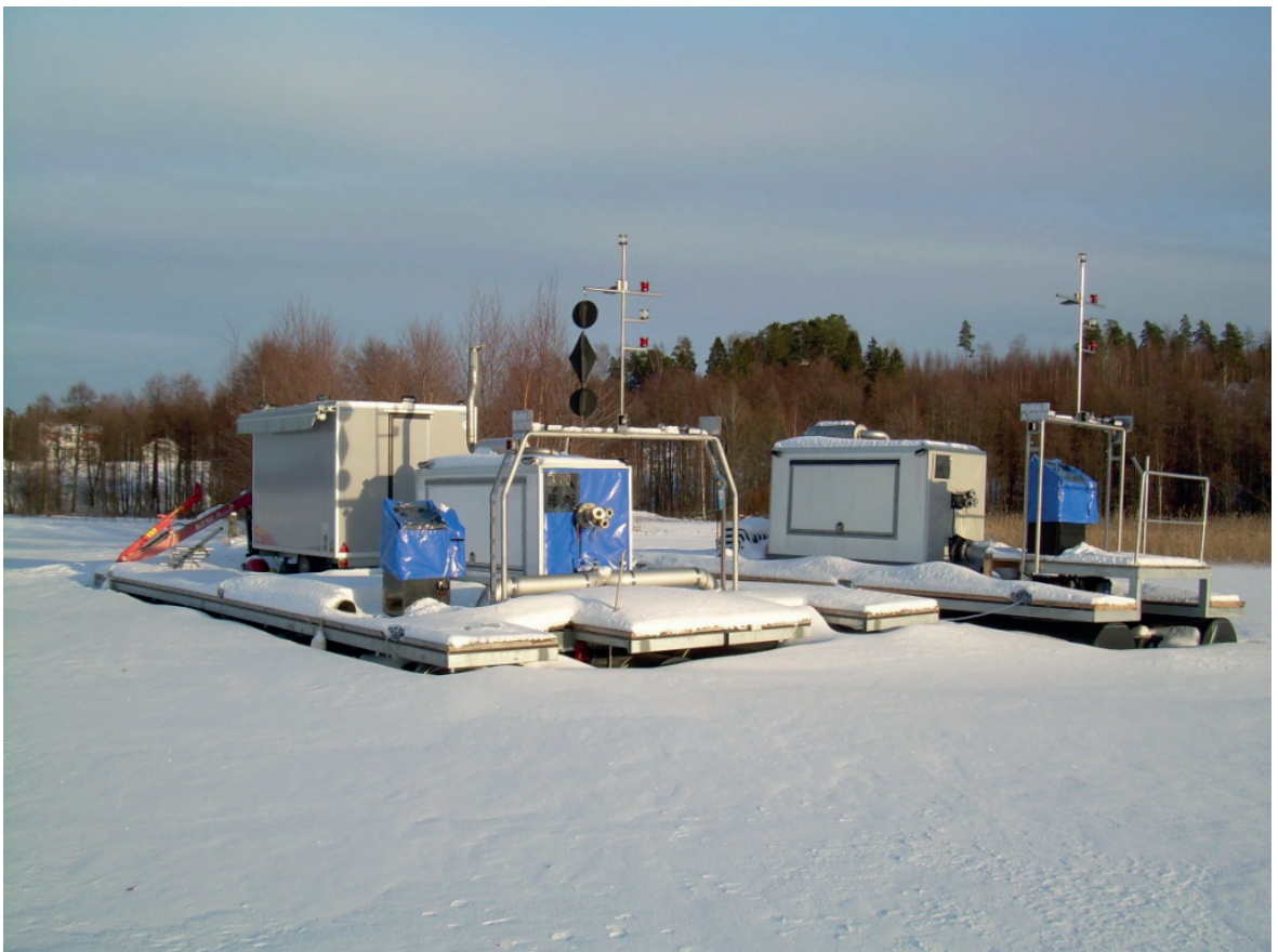
Kuva 4. Nummelanselältä otettiin kaasuputkityömaahan liittyviä näytteitä myös silloin, kun työ oli pysähdyksissä. Helmikuussa 2011 putken uittamisessa käytetyt lautat olivat rannassa.
